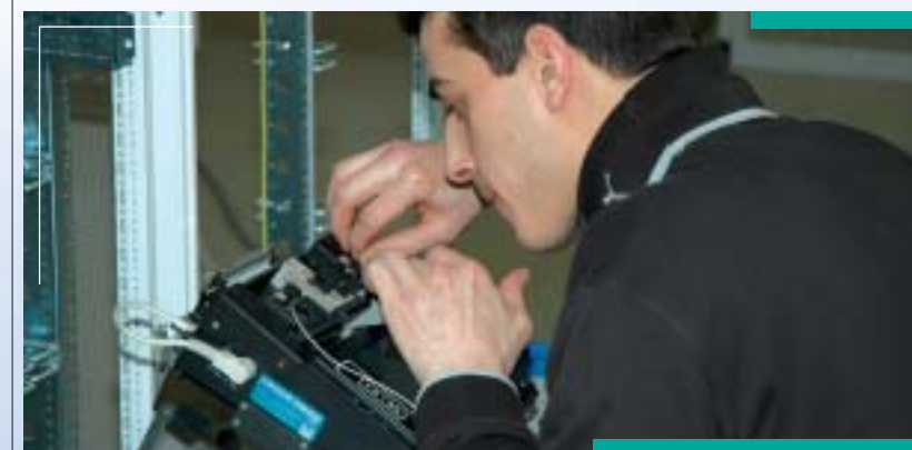
La fusion des fibres optiques, une opération délicate exigeant une précision absolue. Pas moins de 4000 fusions seront effectuées pour le chantier du bâtiment du Groupe Caisses d'Epargne.
